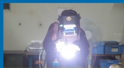
B. Welding Area
